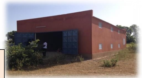
Magasin (entrepôt) de proximité construit par l'UGCPA dans le village de Ouarkoye au profit des membres des organisations paysannes de Kosso, Sokongo et Doudou
